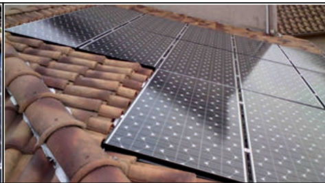
мощност - 3kWp, местоположение - Leguevin / FR
