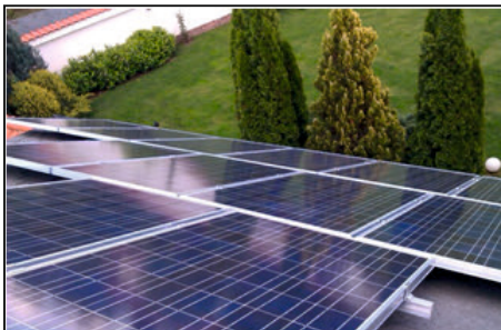
Автономна фотоволтаична система 4,6 kWp, 900 Ah, 48 V / 230 V
