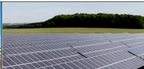
мощност - 7.50MWp, местоположение - Rüdersdorf/Gera / DE
