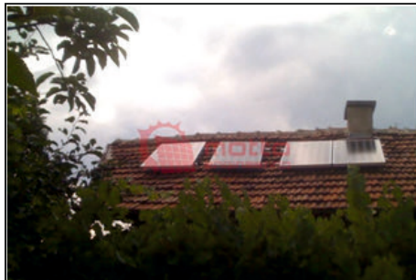
Автономна фотоволтаична система 0,92 kWp, 450 Ah, 24 V/230 V
