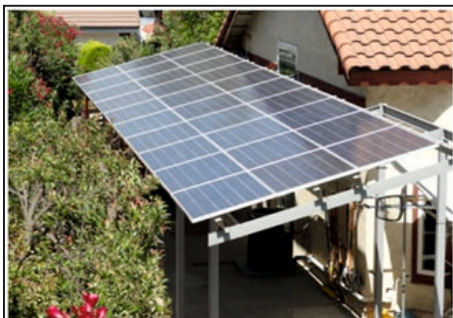
Фотоволтаичен паркинг - 1.92 kWp
