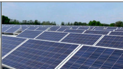
мощност - 200kWp, местоположение - Rangsdorf / DE
