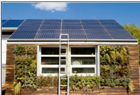
Автономна фотоволтаична система 1,15 kWp, 450 Ah, 24 V / 230 V
