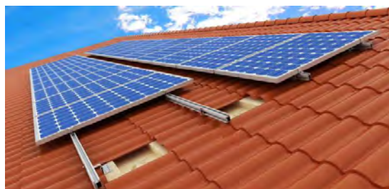
Фигура 2.26: Монтаж на фотоволтаични модули на покриви и други фасадни елементи чрез монтажни шини и държачи
