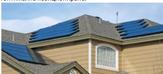
Фигура 2.3: Фотоволтаични панели поставени на покрив с различен наклон и ориентация
